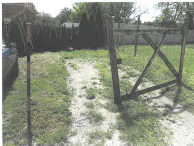
Rozvod plynu( tlakové potrubie do 400kPa
