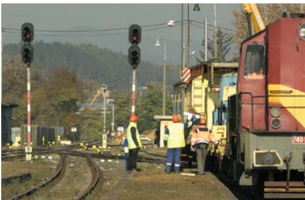
a vasúti szakasz villamosítása
