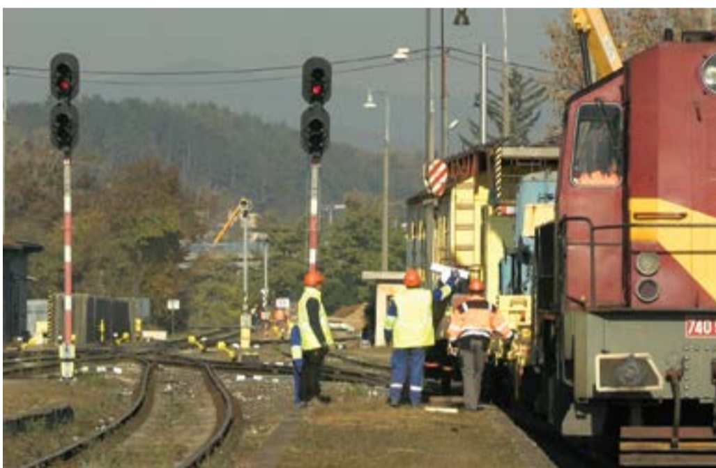
Elektrifikácia železničného úseku
