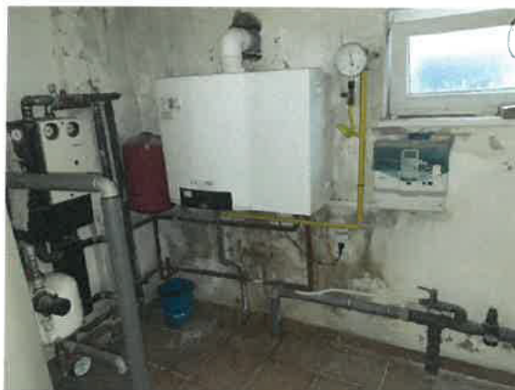
Zariadenia v kotolni – vykurovanie a príprava TÚV
